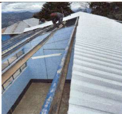
Foto 3: Sustitución de lámina, por lamina troquelada aluzinc calibre 26
