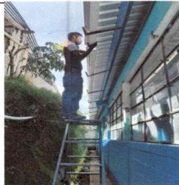
Foto 4: Sustitución de canal pvc
