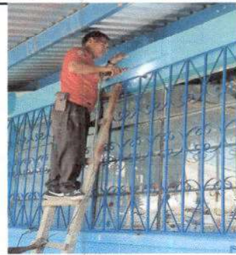
Foto 2: Fabricación e instalación de balcones de hierro en ventana
