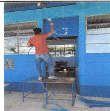
Foto 6: Mantenimiento de puertas de metal
