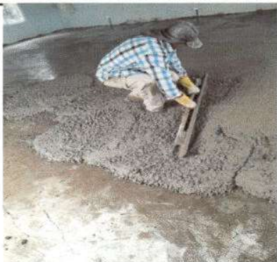
Foto1: Sustitución de piso prefabricado por torta de concreto
