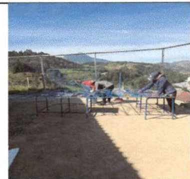
Foto 5: Mantenimiento a balcones de metal
